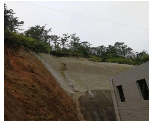
项目南面山地
