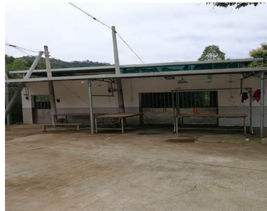
项目所在建筑现状
