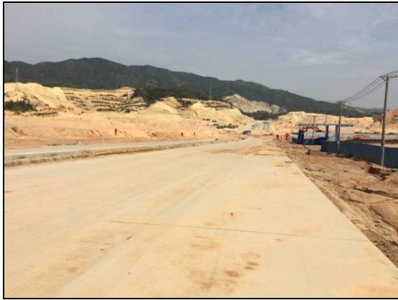
项目西侧——40m 宽道路（F 路）
