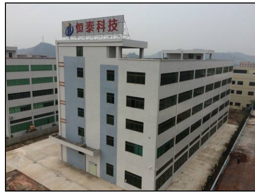
项目北侧—园岭大道
