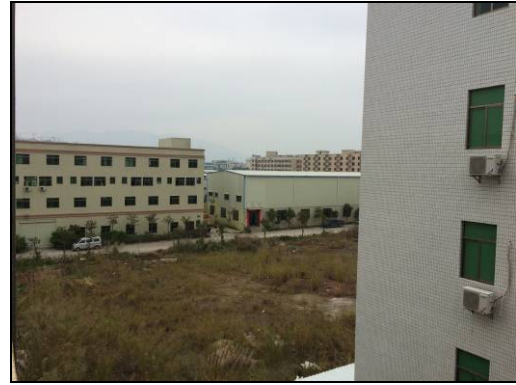
项目西侧—紫金县焯耀电子科技有限公司厂房
