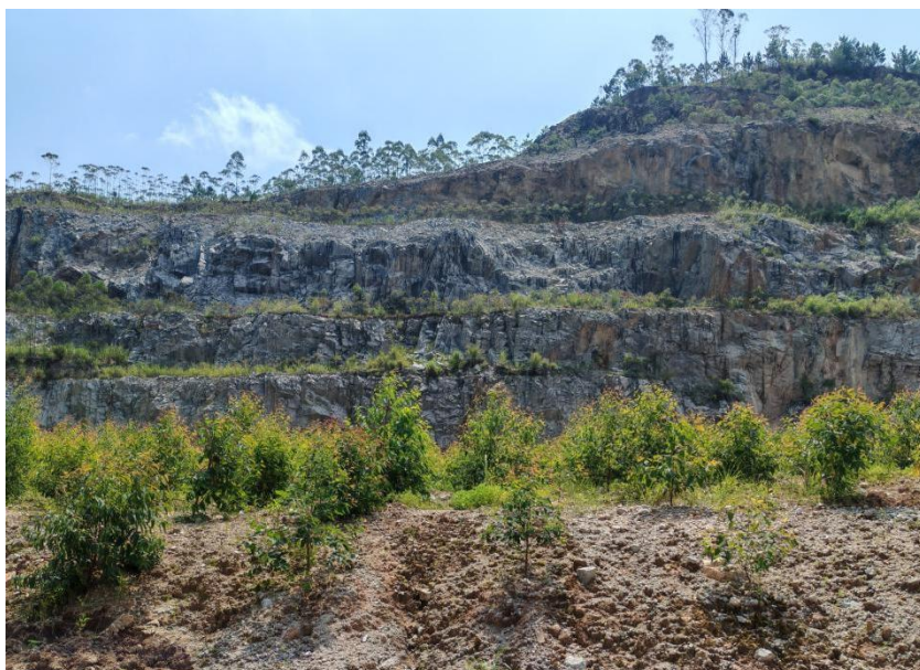
图4-4 露天采场植被（桉树）重建完工现场照片
