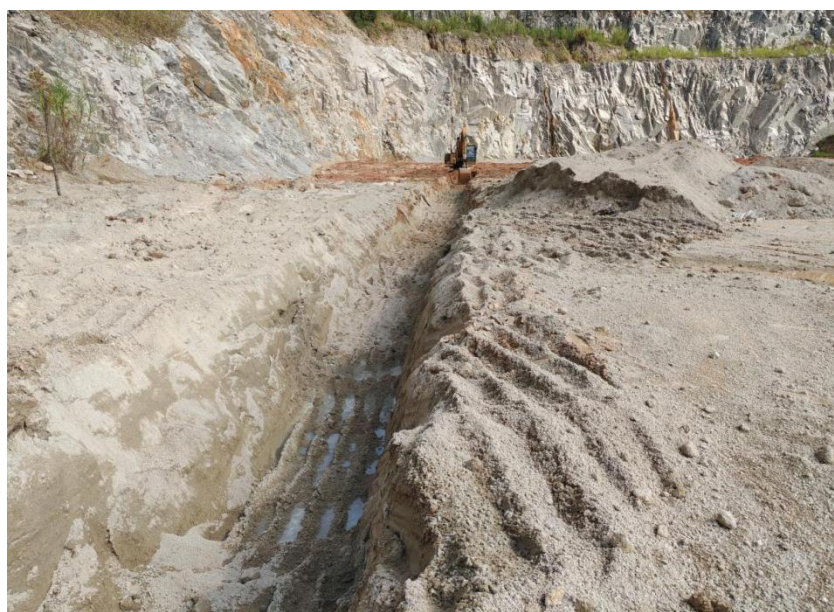
图4-1 露天采场修建排水沟施工照片
