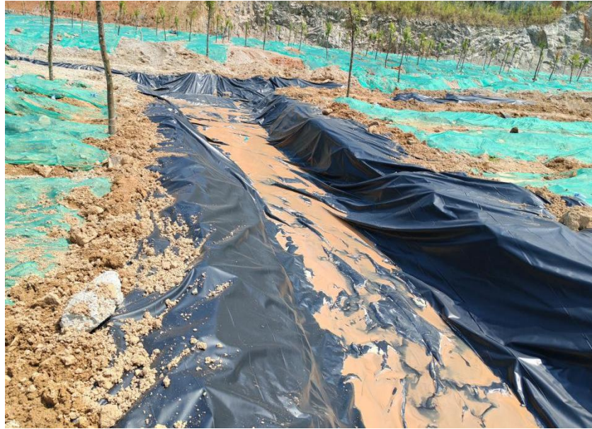
图4-2 露天采场修建排水沟完工照片
