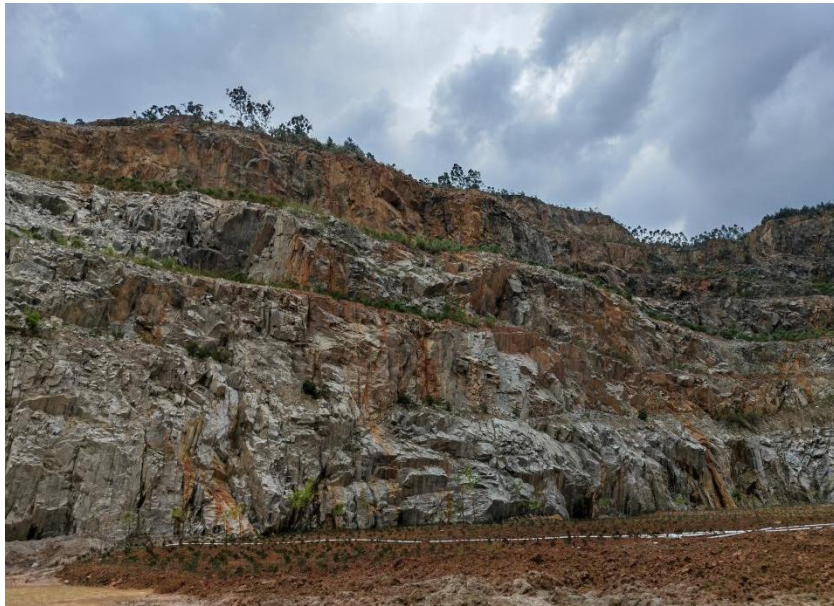
图4-3 露天采场植被重建施工现场照片
