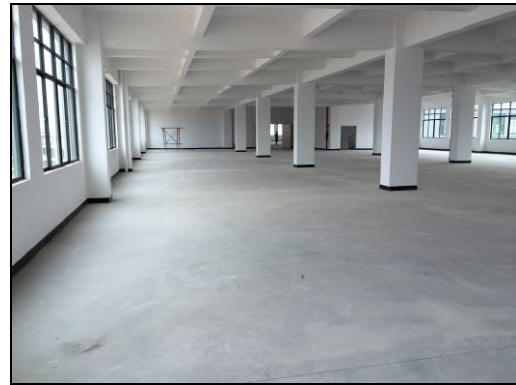
1号厂房第3层现状
