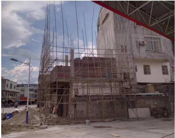
西面-中联圩楼房
