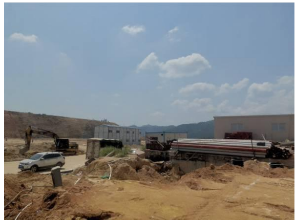
项目选址南侧现状工业园建设用地
