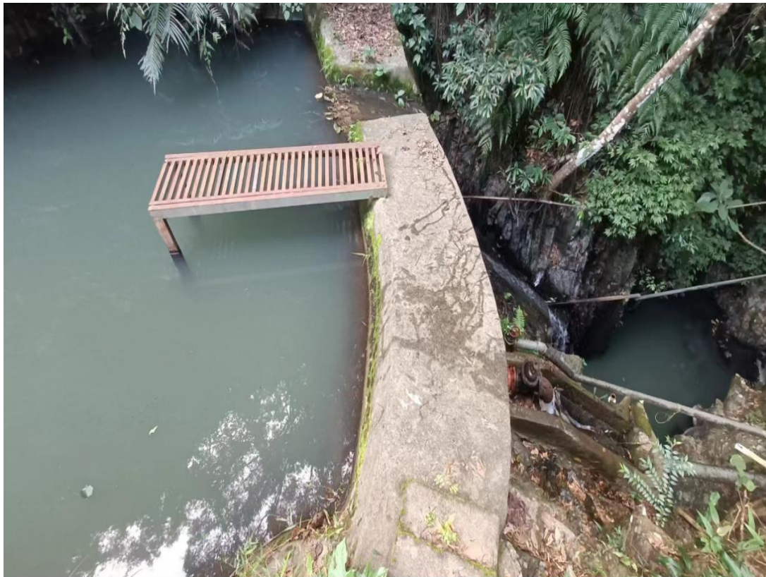
图 3.4.3-2 拟新增紫城镇龙潭村马头嘴水源地取水口现场照片
