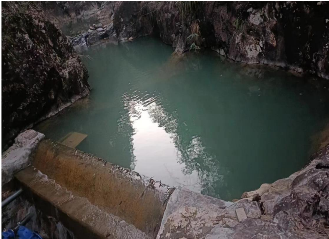
图 3.4.1-2 拟新增上石村侯寨地水源地取水口现场照片
