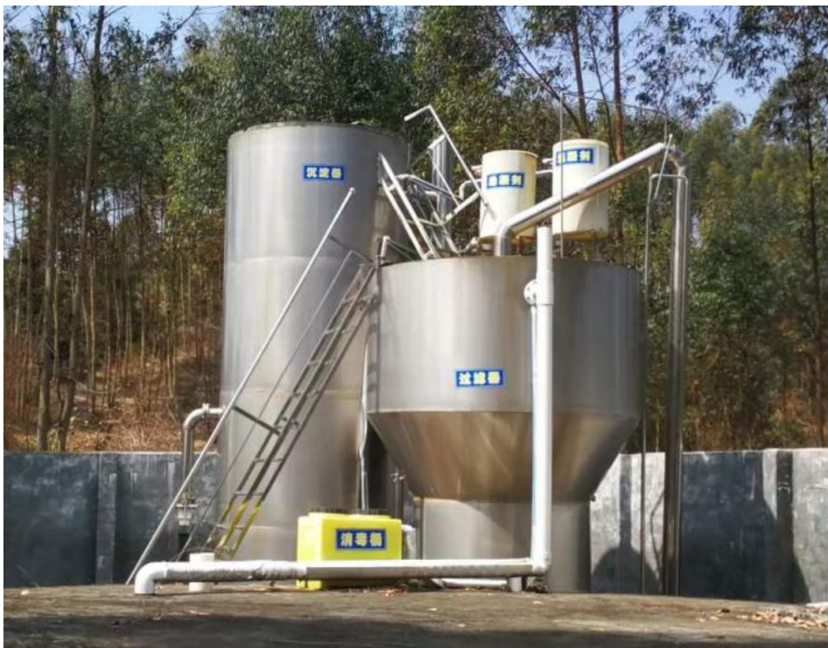
图3.5-1 一体化净水设施现场照片
