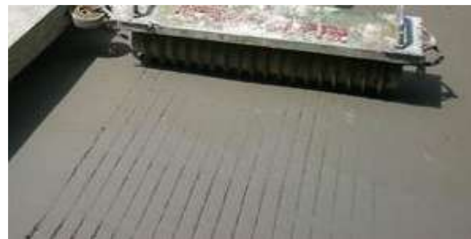
路面压纹防滑示例
