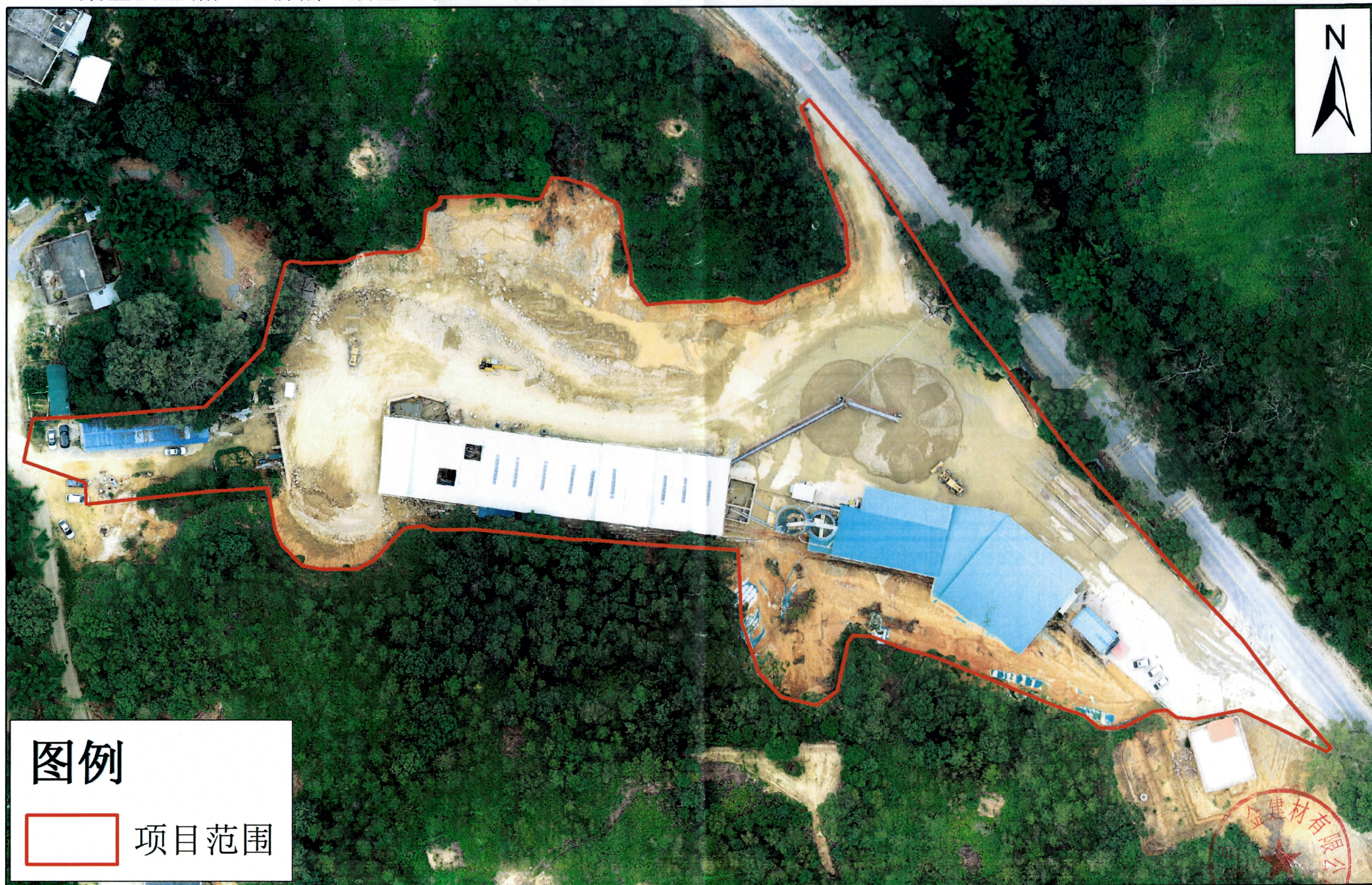
紫金县蓝塘产业新城一期基础设施（含安置区）配套一部分市政道路及地块土石方建设项目复垦前影像图
