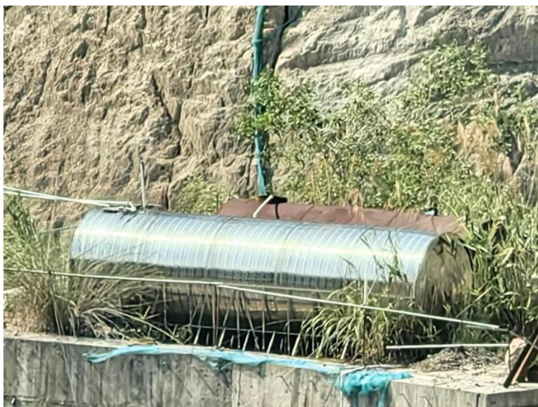
图4-9 露天采场储水罐现场照片
