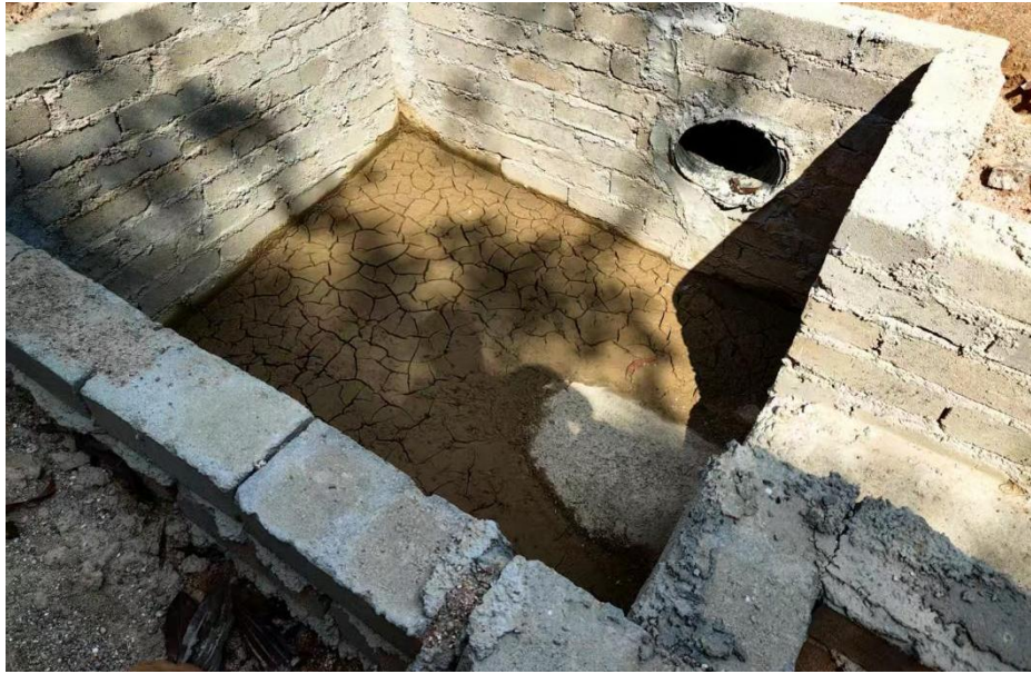
图4-3 修建的1#沉砂池现场照片
