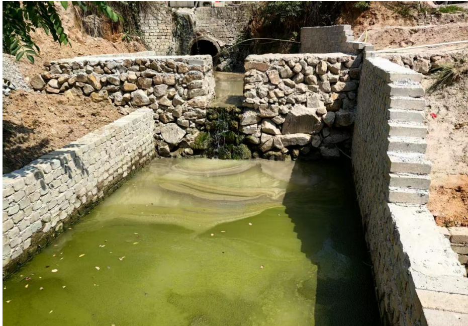
图4-4 修建的3#沉砂池现场照片
